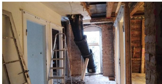
Die schlechte Nachricht ist, dass beim Öffnen der Konstruktionen ein über den geplanten Umfang hinausgehender Hausschwammbefall festgestellt wurde. Insbesondere in bislang nicht zugänglichen Bereichen des Mansarddaches und der Deckenaufleger am Balkon sowie in den Kehlen sind tragende Holzbauteile zerstört, die nun saniert werden müssen. Wir rechnen nach vorsichtiger Schätzung mit zusätzlichen Kosten in Höhe von 50.000 €.
