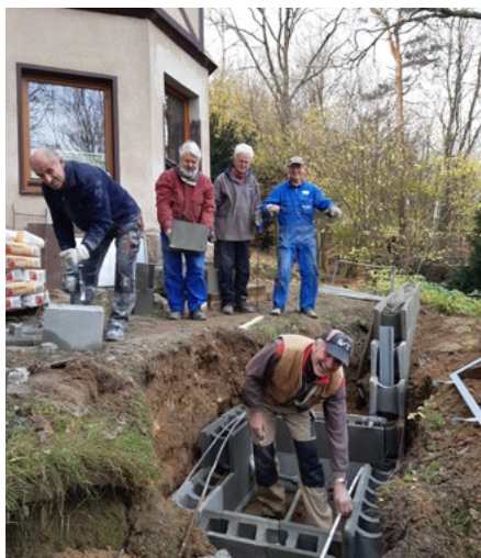
Terrassenbau an der Ferienwohnung
